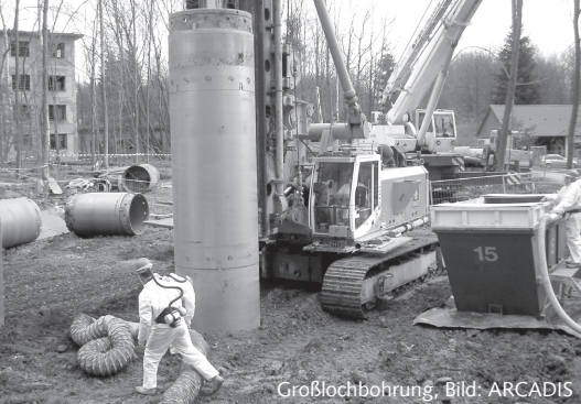
Großlochbohrung, Bild: ARCADIS
